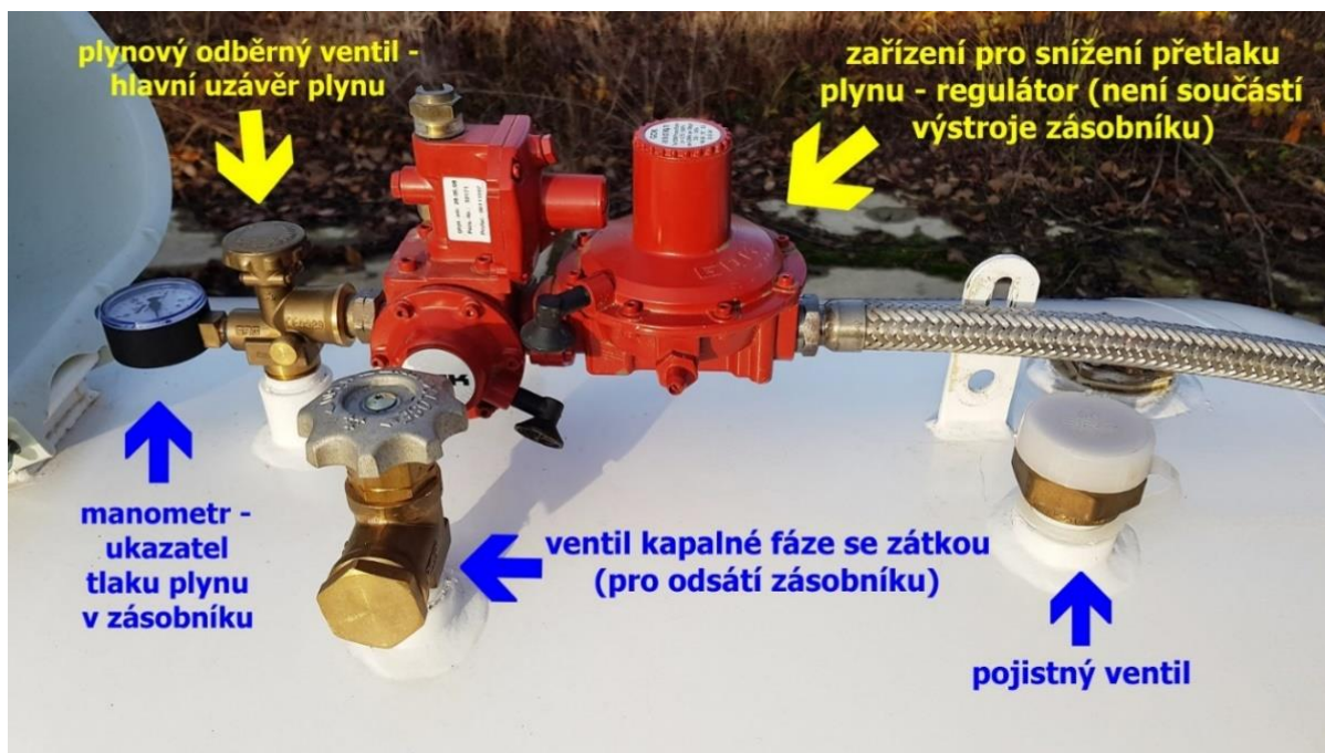
Obrázek 3: Výstroj zásobníku ze strany, kde je umístěn (mimo kryt armatur) pojistný ventil
