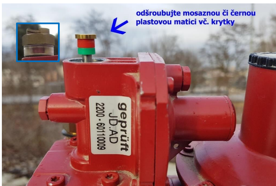
Obrázek 5: Postup odšroubování matice vč. krytky
