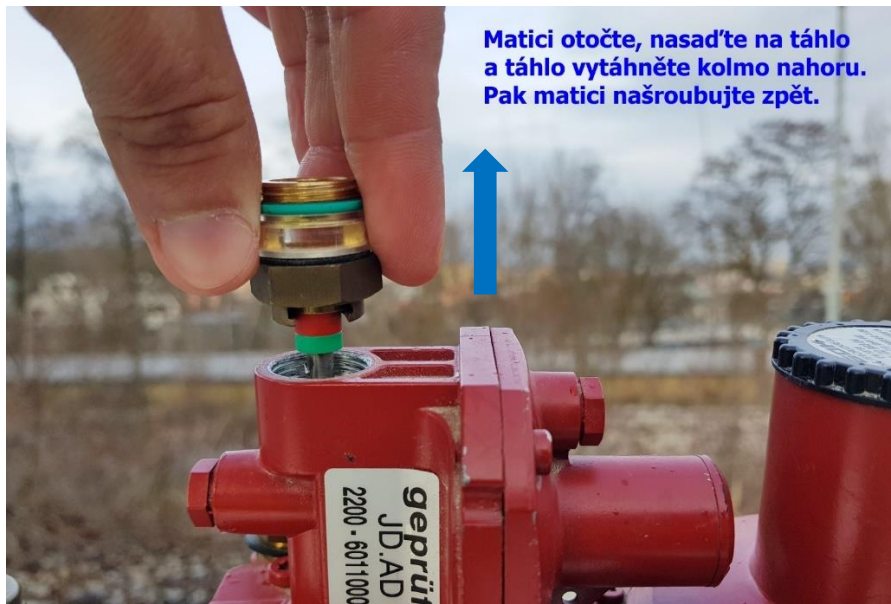
Obrázek 6: Postup vytáhnutí táhla
